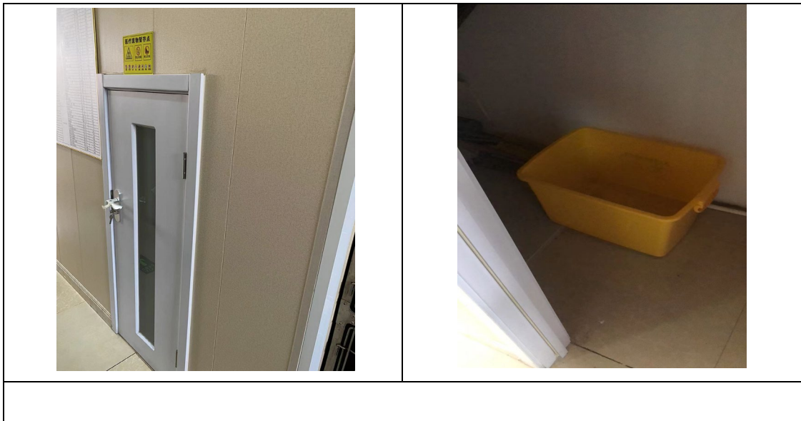
图 7 现有医疗废物暂存间照片
